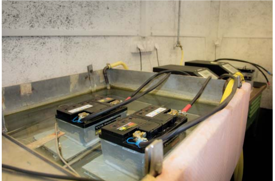
Les températures prescrites de la batterie sont maintenues constantes dans le bain.
